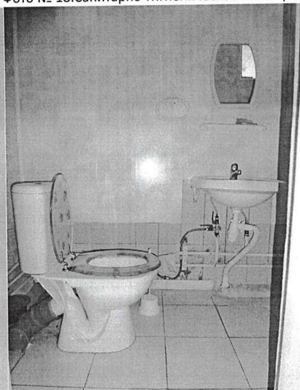
Фото № 18. Санитарно-гигиеническое помещение.
