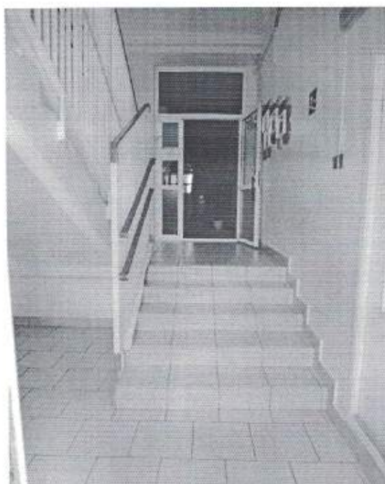
Фото № 6. Лестница внутри здания.
