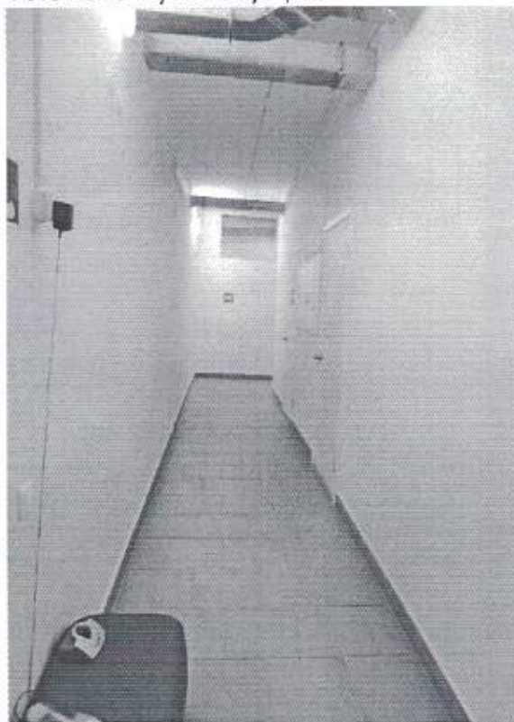
Фото № 15. Пути эвакуации.
