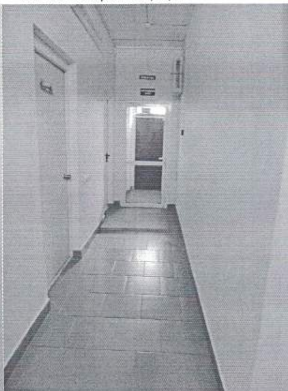
Фото № 16. Пути эвакуации.
