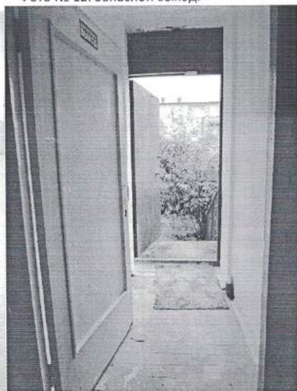
Фото № 12. Запасной выход.
