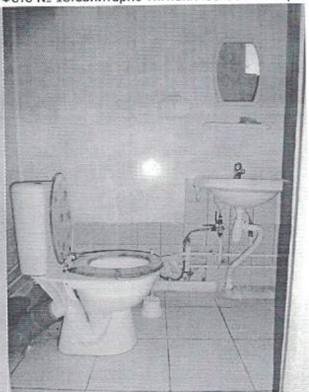
Фото № 18. Санитарно-гигиеническое помещение.
